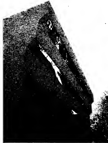
صورة (٢٥٧): منظر خارجي لمكتبة جامعية لاحظ استخدام النوافذ المائلة لتجنب تغفل أشعة مباشرة إلى المبنى
